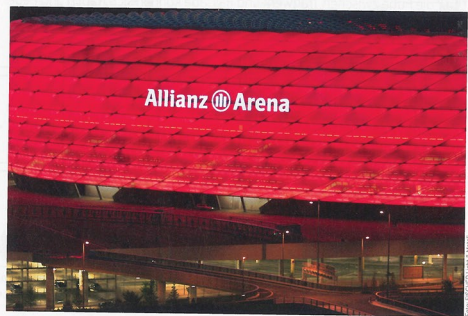
Attraktives Markenzeichen: Der Schriftzug der Allianz Arena in München ist 40 Meter lang und wiegt drei Tonnen. Vor der Auftragsvergabe wurde auch der Brandfall getestet.
