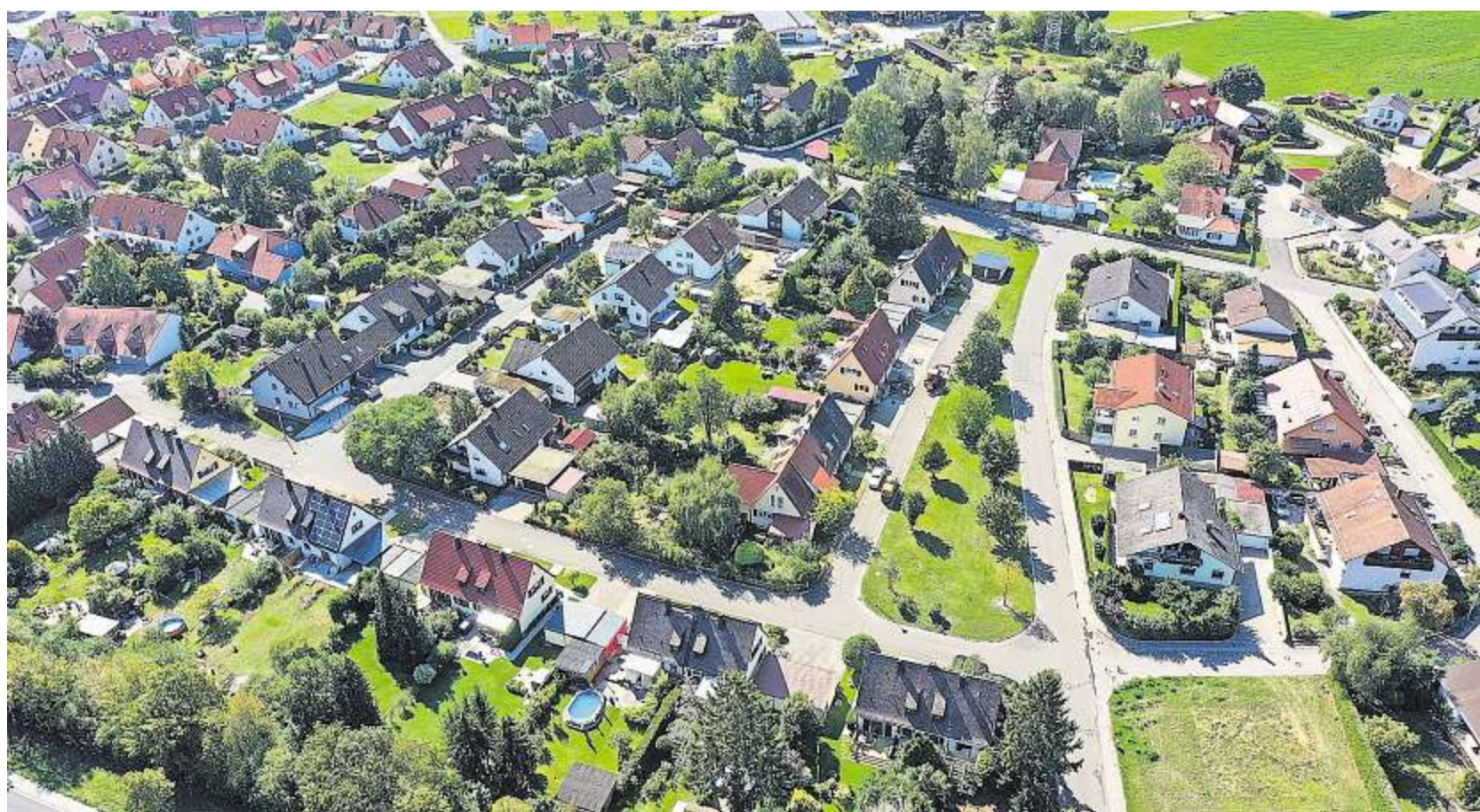
Die Fischersiedlung war ein soziales Wohnungsbauprojekt des gleichnamigen Unternehmens.
